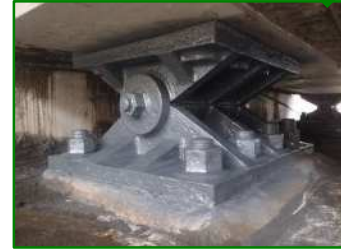
支承再塗装(下塗り施工後)
