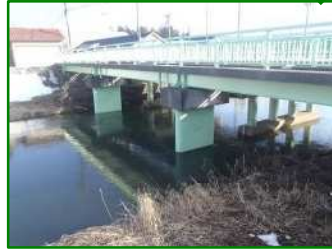
ハイルベント杭喫水線防食(補修後)
