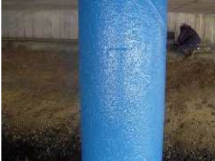
軽量栈橋鋼管杭
