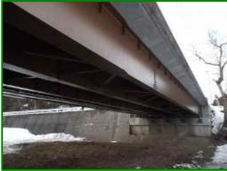
橋梁桁端部(補修後)
