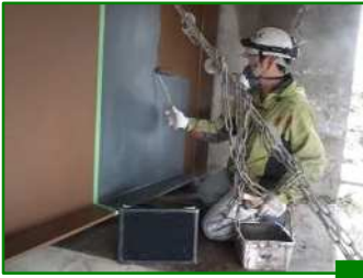
橋梁桁端部(補修中)
