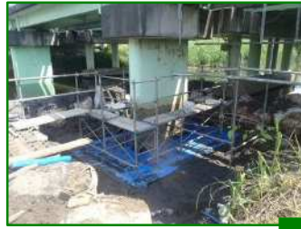
ハイルベント杭喫水線防食(補修中)
