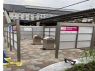
(2)屋外設置(パーテーション型)
