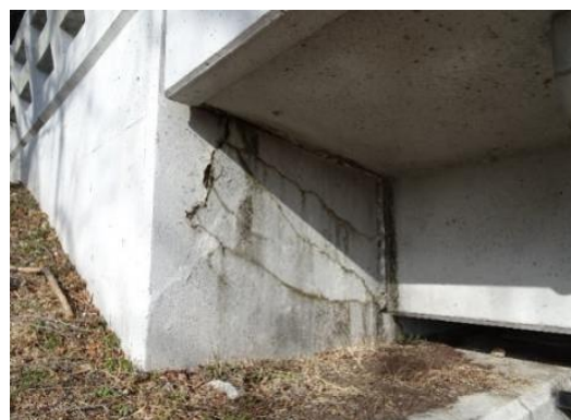
図 3.3-1 橋梁の劣化状況
