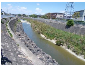
護岸（特殊堤を除く）
