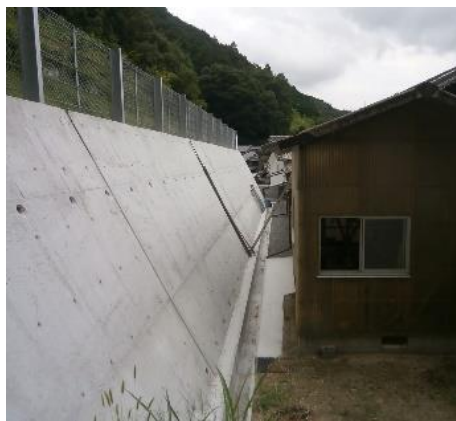
急傾斜地崩壊防止施設 （擁壁工）
