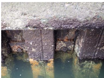
鋼材の腐食
