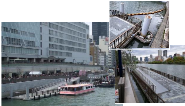
「八軒家浜防災船着場（浮棧橋）」
