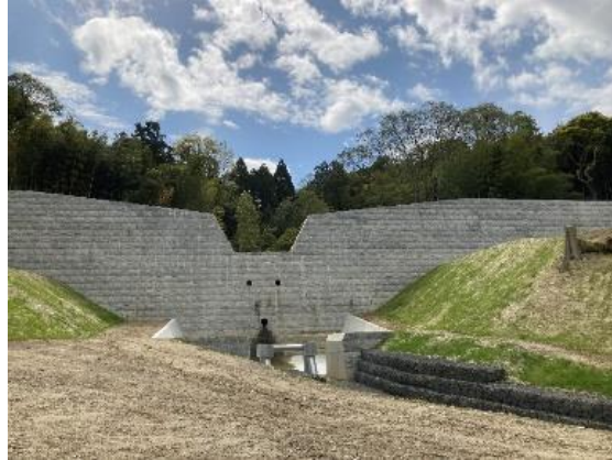
不透過型砂防堰堤
