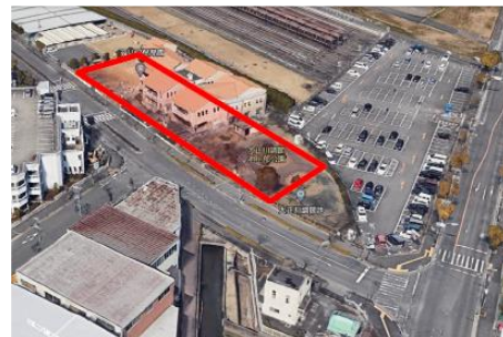
地上の状況 (大正川調節池)
