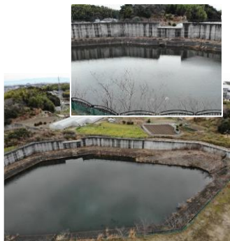
住吉川防災調節池
