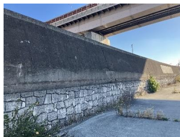
特殊堤（コンクリート）
