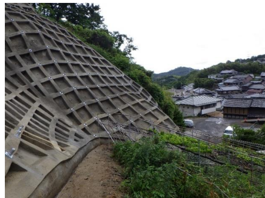
急傾斜地崩壊防止施設 （法枠工）
