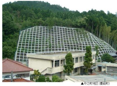
急傾斜地崩壊防止施設 ▲中之町地区(豊能町)
