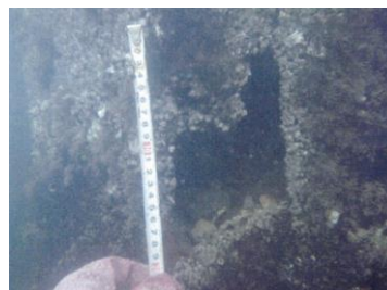
鋼材の貫通孔（水中部）
