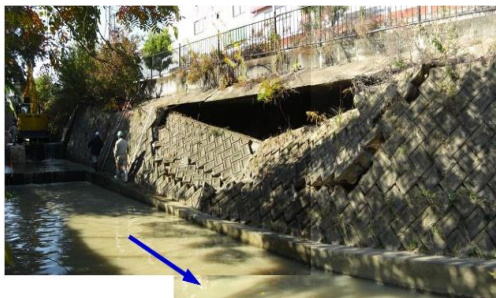
図 3.1-5 護岸の崩壊
