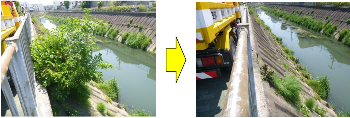
図 3.1-37 直営作業による雑木の伐採
