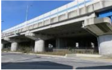
橋梁 神田高架橋 176号／池田市
