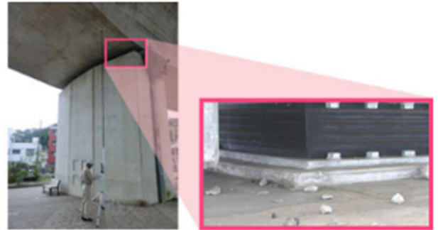
図 3.9-21 点検ロボット
