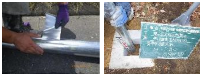
図 3.7-3 防食テープの設置
