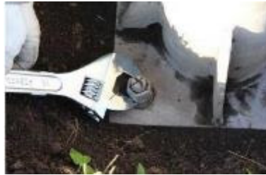
図 3.7-2 ボルト・ナットの増し締め
