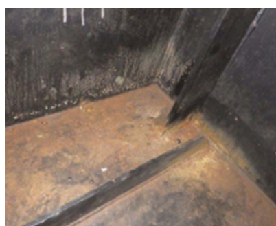
内部の腐食
