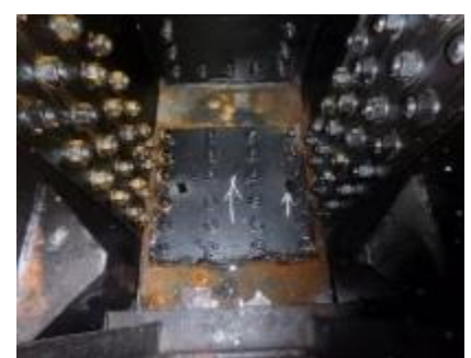
内部の腐食
