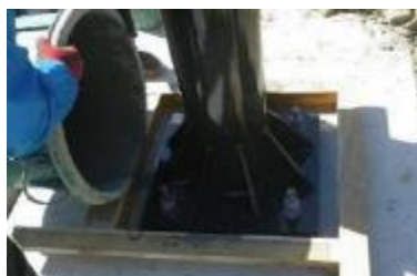
図 3.7-4 無収縮モルタルの充填
