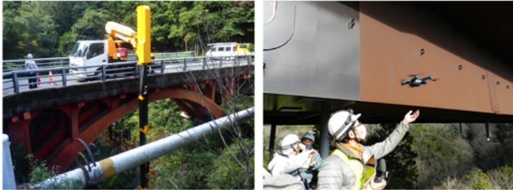
図 3.1-5 橋梁の点検実施状況
