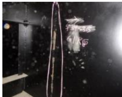
内部の腐食
