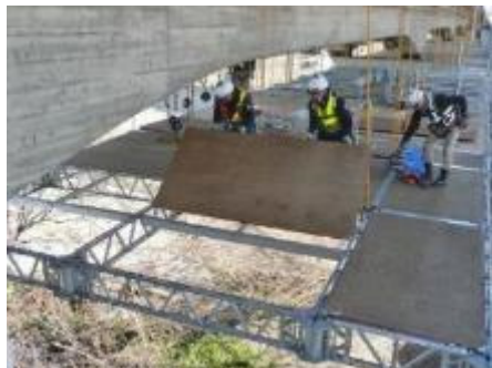
図 3.9-23 安全性向上：パネル足場
