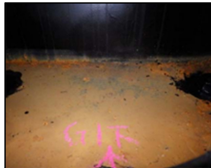
内部の腐食
