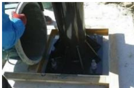
図 3.5-6 無収縮モルタルの充填
