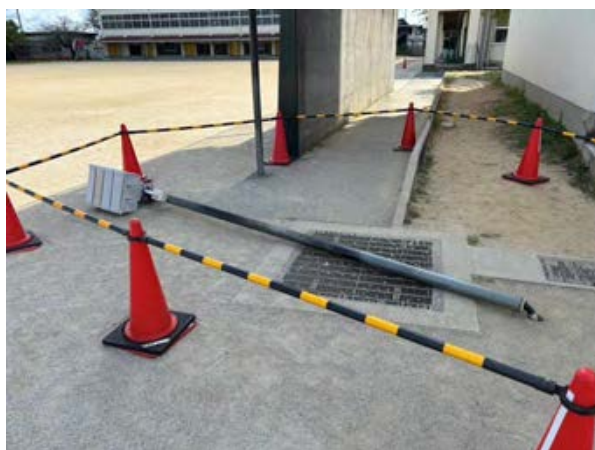
倒れたスピーカーの支柱
