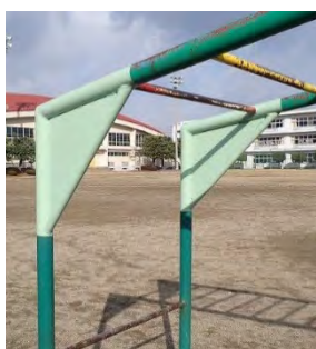
写真30 開口部を全て埋めた対策例
