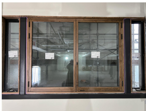
複層ガラスインナーサッシ (施工中)
