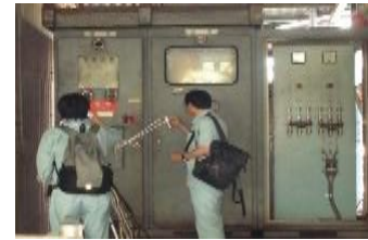
PCB廃棄物に係る立入検査
