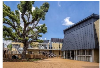
第 42 回大阪都市景観建築賞 大阪府知事賞 (守口市立さくら小学校)
