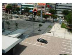
透水性・保水性舗装
