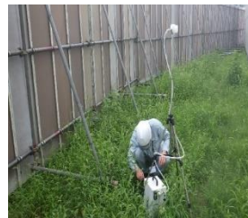
大気中の石綿濃度測定
