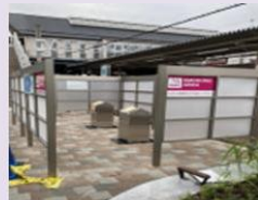
(1) 屋外設置（パーテーション型）
