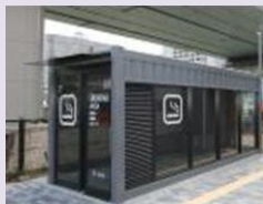
(1) 屋外設置（コンテナ型）
