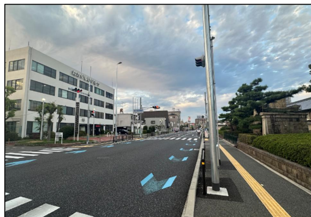
電線共同溝による無電柱化 (堺阪南線(高石市))
