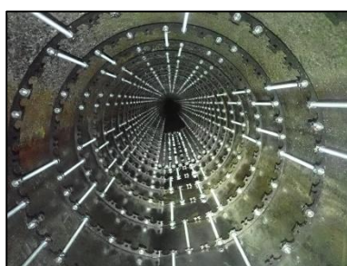
補強リング設置状況
