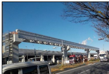
鋼軌道桁架設工事
