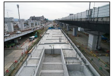
車両基地整備工事
