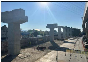
支柱建設工事
