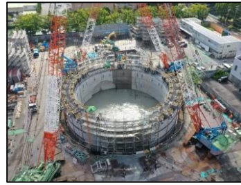
寝屋川北部地下河川城北立坑
