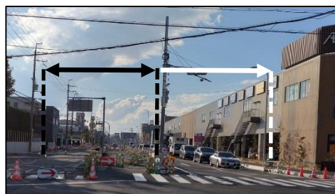
都市計画道路の整備による延焼遮断空間の確保 （三国塚口線）
