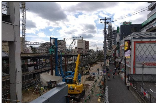
京阪本線 香里園駅（仮駅舎工事）
