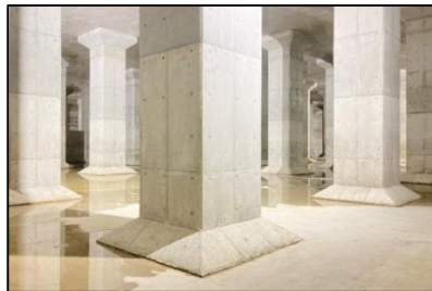
布施公園調節池
