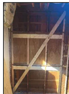
木造住宅 筋交い設置
