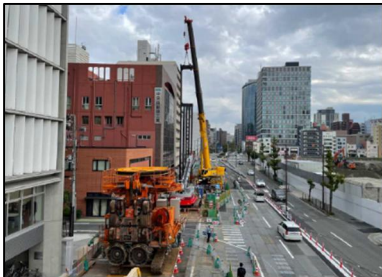
中之島駅部（土留工）
