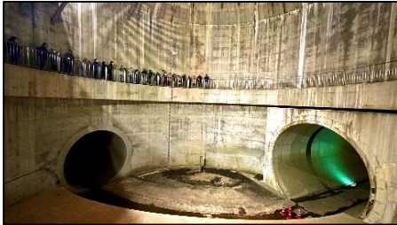
南部地下河川若江立坑（地下部）
