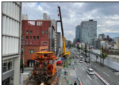
中之島駅部（土留工）
