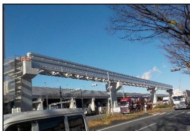
鋼軌道桁架設工事
