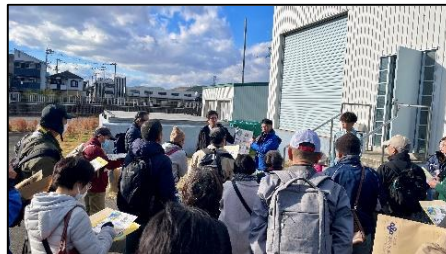
南部地下河川若江立坑（地上部）
