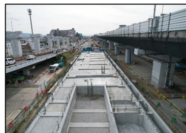
車両基地整備工事
