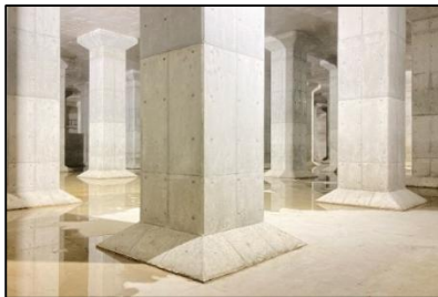
布施公園調節池
