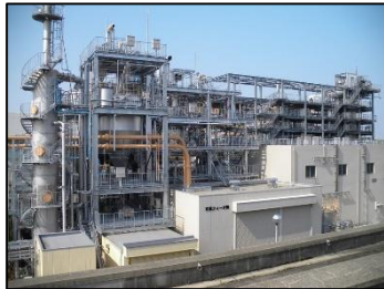
温室効果ガス排出量の少ない 次世代型焼却炉の導入 (中央水みらいセンター)
