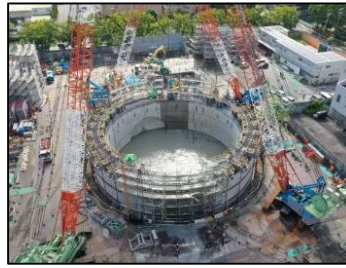
寝屋川北部地下河川城北立坑
