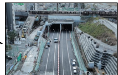
万博のアクセスルートとしての暫定整備状況 （淀川左岸線（２期））
