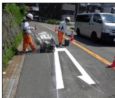
路面標示の補修
