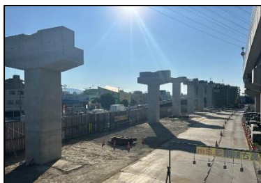
支柱建設工事
