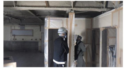
解体現場の立入調査
