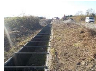
堺第7-3区での排水路改修工事
