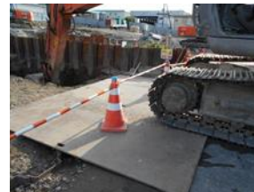
汚染土壌掘削工事の現地確認状況
