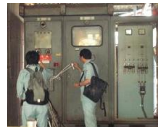
PCB廃棄物に係る立入検査
