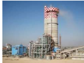
肥料プラント (水素大量製造)
