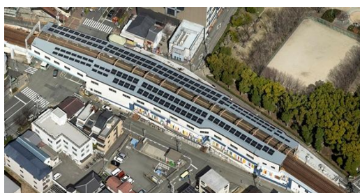
阪神杭瀬駅に設置の太陽光パネル
