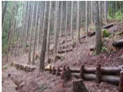
本数調整伐と筋工の施工
