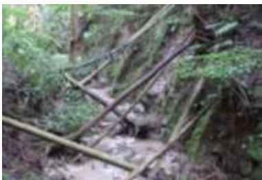
溪岸侵食による溪流への倒伏
