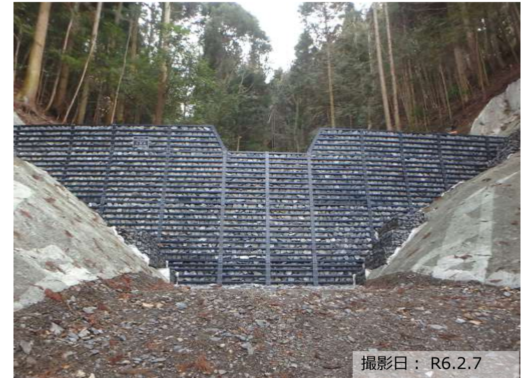
写真① 治山ダム（鋼製）の設置状況
