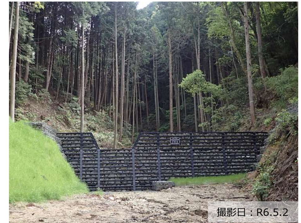
写真① 治山ダム（鋼製）の設置状況
