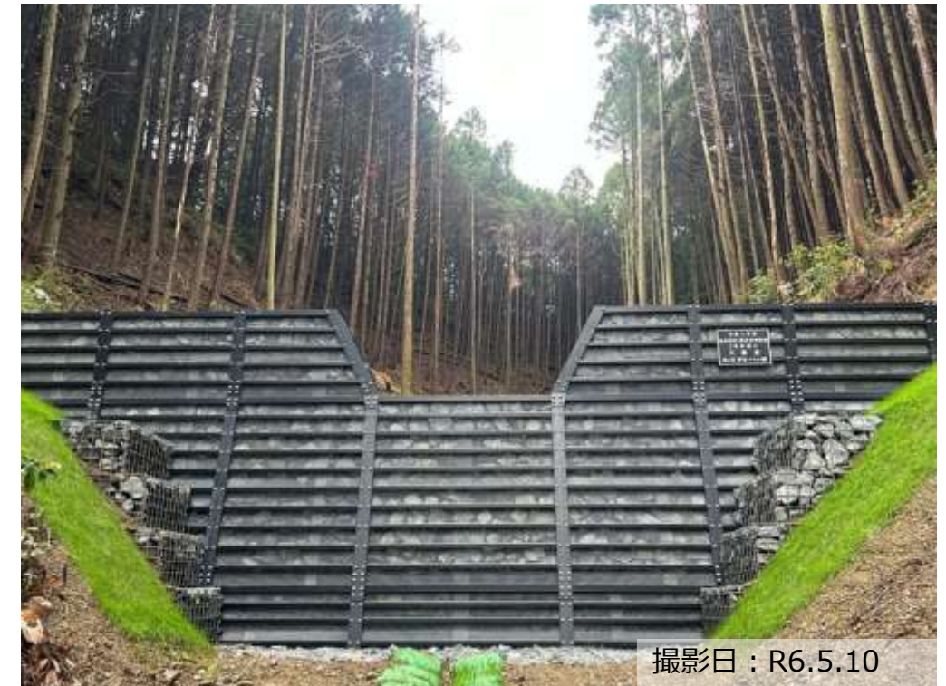
写真① 治山ダム（鋼製）の設置状況
