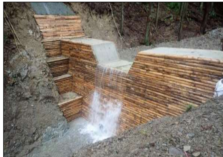
治山ダムの設置により、渓流勾配を緩和し、土石流の発生を未然に防止(貝塚市)
