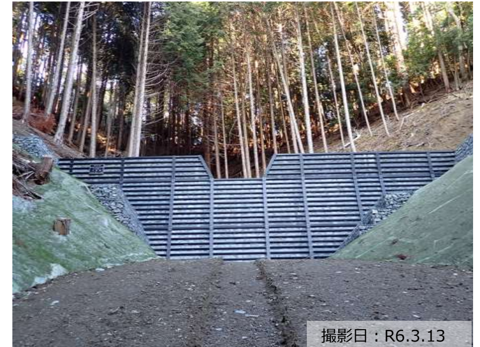
写真① 治山ダム（鋼製）の設置状況
