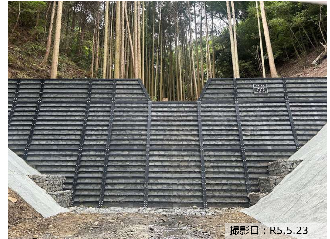
写真① 治山ダム（鋼製）の設置状況
