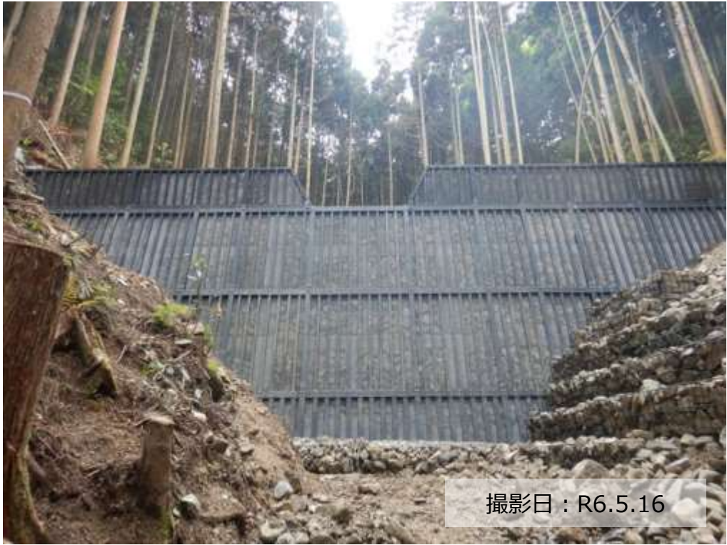
写真① 治山ダム（鋼製）の設置状況
