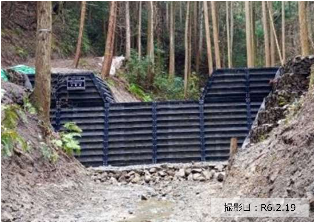
写真①② 治山ダム（鋼製）の設置状況
