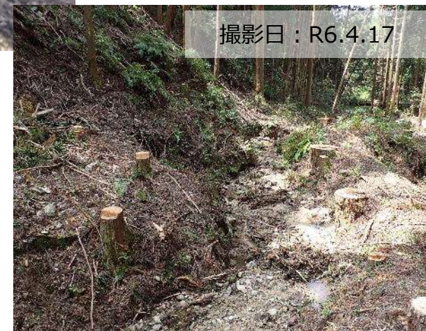
写真② 流木対策の完了状況
