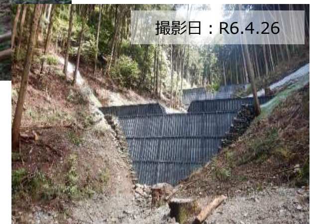
写真② 流木対策の完了状況
