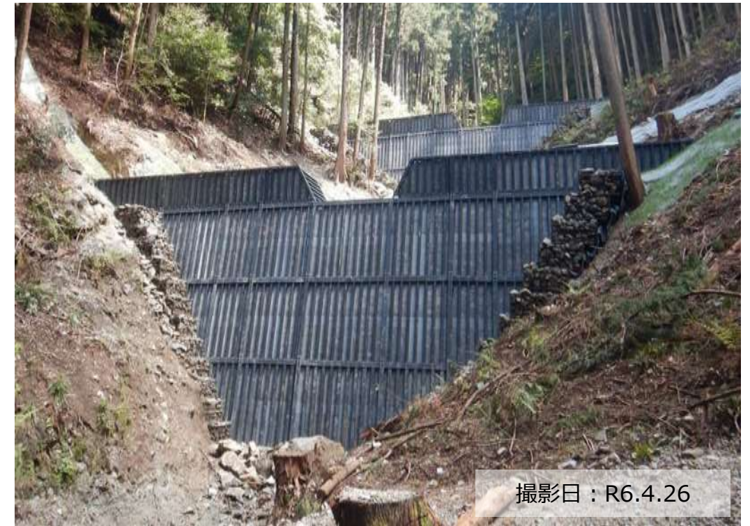
写真① 治山ダム（鋼製）の設置状況
