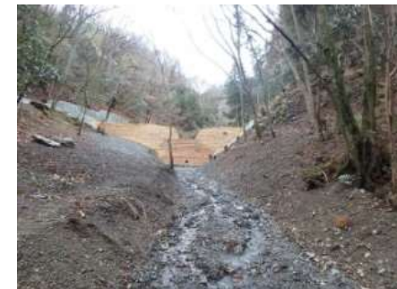
渓流沿いの危険木の除去
