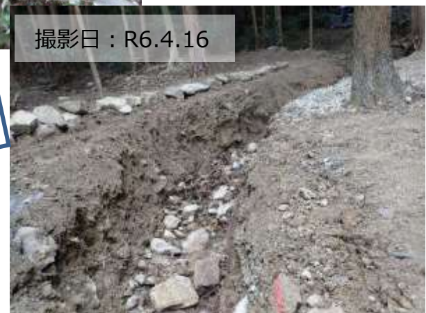
写真② 流木対策の完了状況
