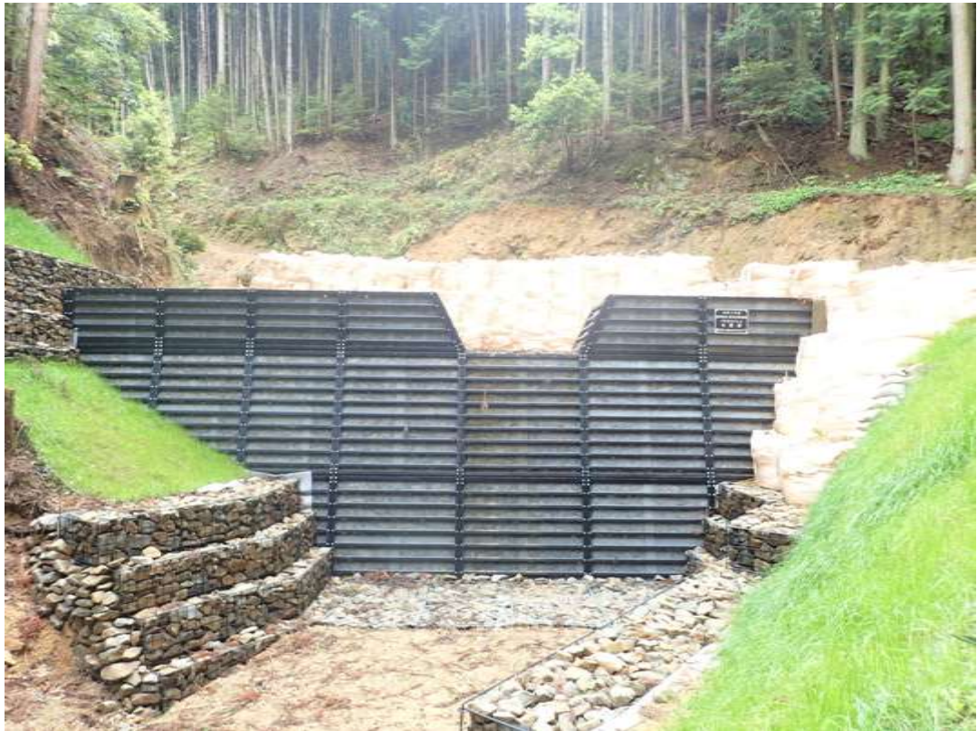
写真① 治山ダム（鋼製）の設置状況
