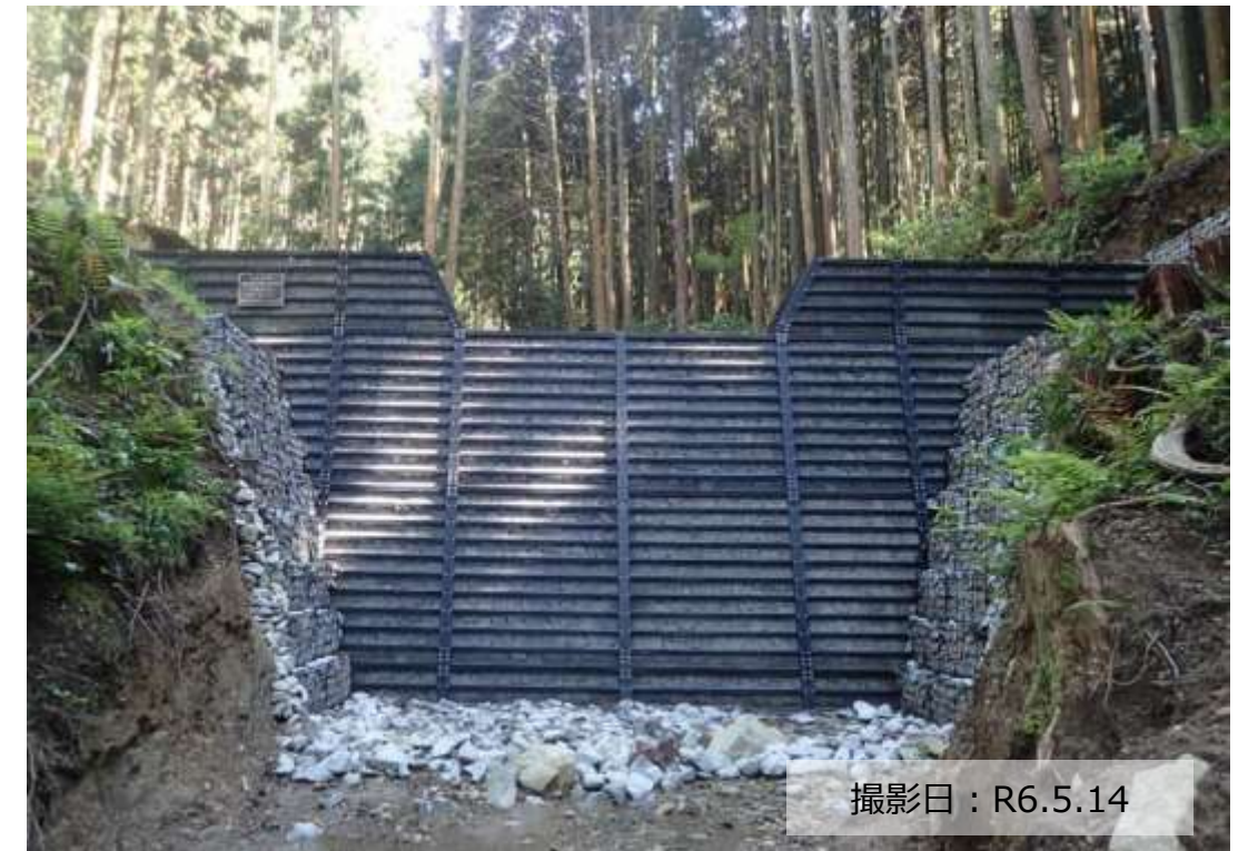
写真① 治山ダム（鋼製）の設置状況
