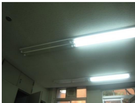
【執務室の部分消灯】
