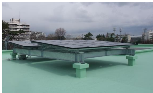
【太陽光パネルの設置】
