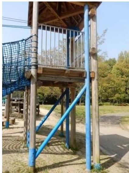
構造部材（支柱）を新たに追加補修し、遊具の延命を図る
