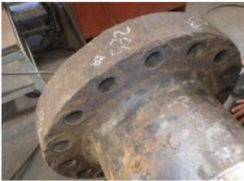
ポンプ軸の腐食状況
