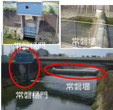
西除川常盤堰・常盤樋門 (堰柱、門柱等のコンクリート部等)
