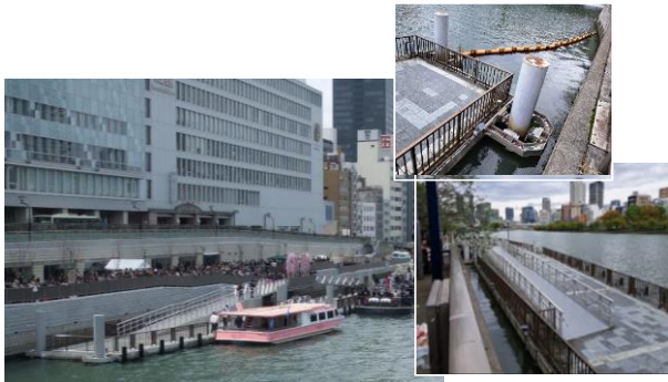
「八軒家浜防災船着場（浮棧橋）」
