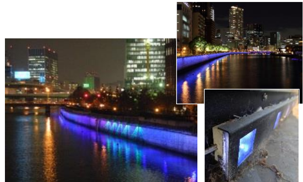
護岸照明施設（大川、堂島川）
