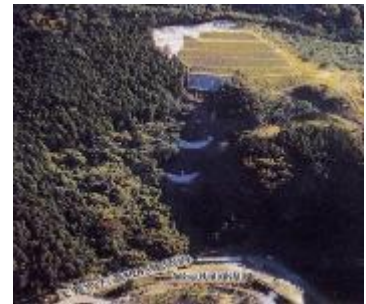
地すべり防止施設
