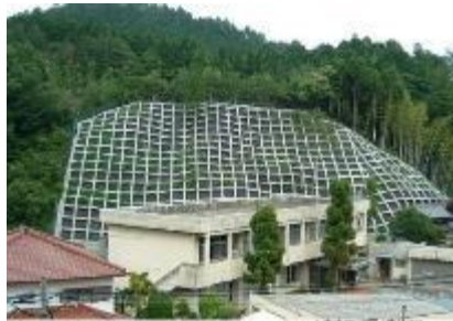
急傾斜地崩壊防止施設
