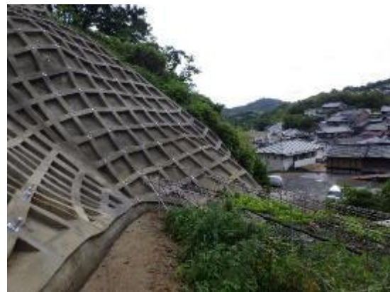
急傾斜地崩壊防止施設 （法枠工）
