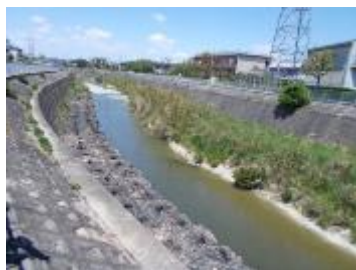
護岸（特殊堤を除く）
