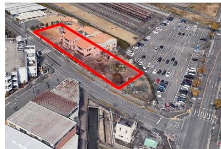
地上の状況 (大正川調節池)
