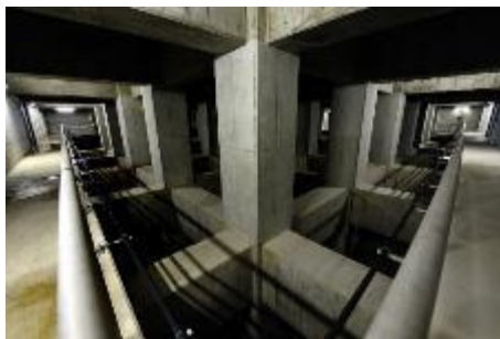
松原南調節池
