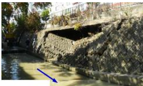
図 3.1-5 護岸の崩壊
