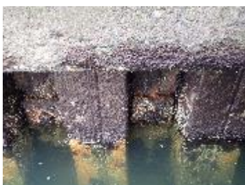
鋼材の腐食
