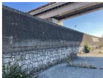
特殊堤（コンクリート）
