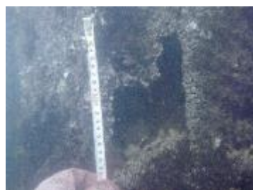
鋼材の貫通孔（水中部）
