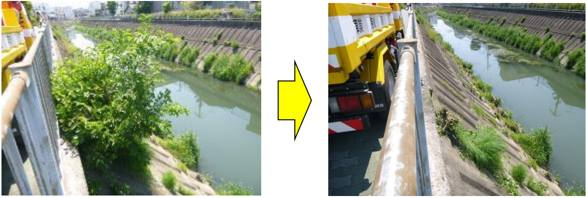
図 3.1-37 直営作業による雑木の伐採
