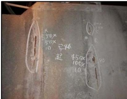
剥離・鉄筋露出
