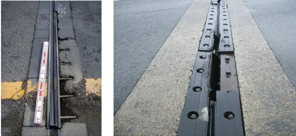
図 3.1-20 損傷ジョイントの様子
