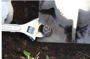
図 3.7-2 ボルト・ナットの増し締め
