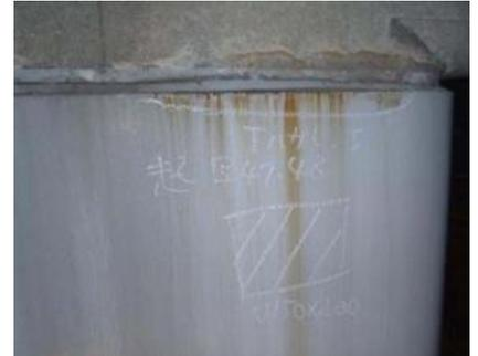
補強材の腐食
