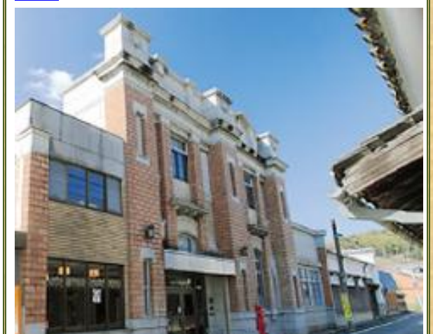
「うすくち龍野醤油資料館」の外観
