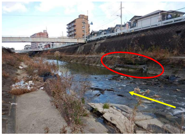
西除川R3-1 護岸の損傷
