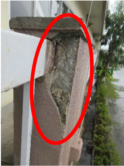
【事例 13】校舎の2階ベランダ立ち上がり壁のコンクリートの一部が落下。 落下片大きさ：9cm×29cm×5.5cm
