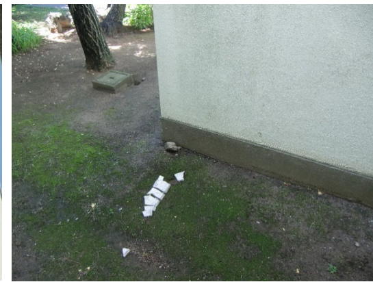
【事例 6】校舎屋上付近の外壁のモルタルの一部が落下。 落下片大きさ：15cm×50cm×1cm（約 1.8 キロ）
