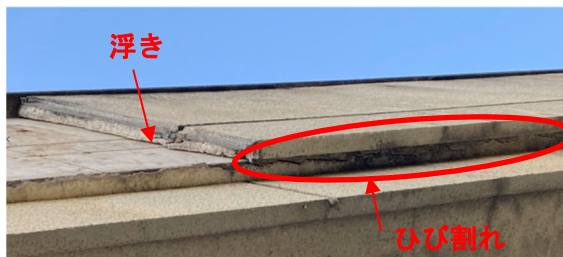
【事例 1】 校舎の屋上付近の外壁のモルタルの一部が落下。 落下片大きさ：85cm×200cm×3.8cm
