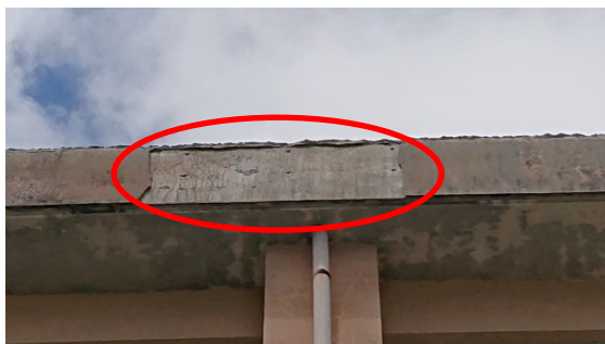
【事例 2】 校舎の屋上付近の外壁のモルタルの一部が落下。 落下片大きさ：30cm×120cm×2cm（約 25 キロ）
