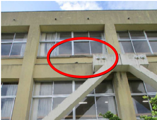
【事例 5】校舎の 2 階窓枠下部外壁のコンクリートの一部が落下。
