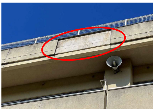
【事例 1】 校舎の屋上付近の外壁のモルタルの一部が落下。 落下片大きさ：85cm×200cm×3.8cm
