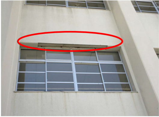
【事例 4】校舎の 2 階窓枠上部外壁のモルタルの一部が落下。 落下片大きさ：20cm×100cm×3～4cm（約 15 キロ）
