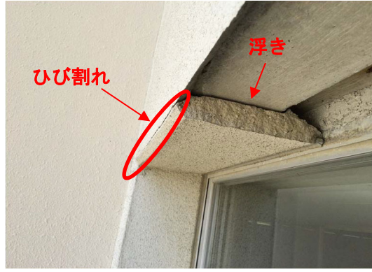
【事例 4】校舎の 2 階窓枠上部外壁のモルタルの一部が落下。 落下片大きさ：20cm×100cm×3～4cm（約 15 キロ）
