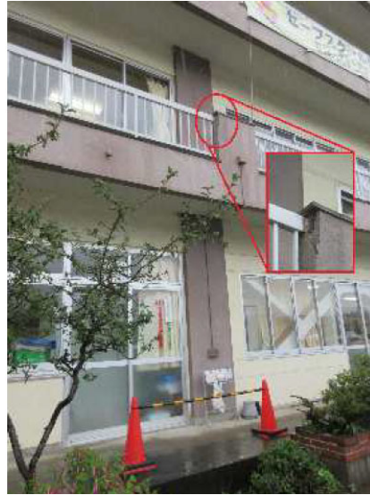
【事例 13】校舎の2階ベランダ立ち上がり壁のコンクリートの一部が落下。 落下片大きさ：9cm×29cm×5.5cm
