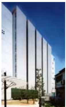
敷地内に設置したポケットパーク
