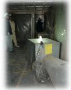
隔離養生区画内（除去作業前）
