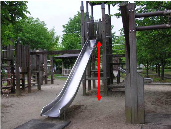
事故発生箇所
