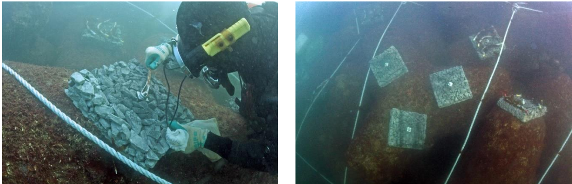
図1-25 基質取付状況（左）、基質設置完了全景（右）
