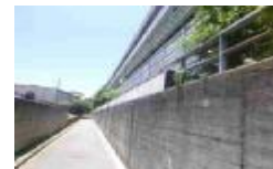
堺（出島）漁港の防潮堤
