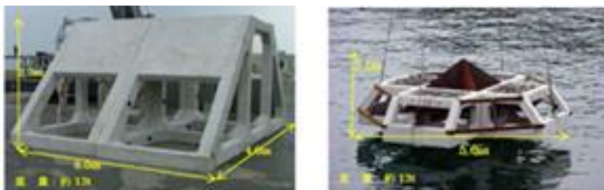
図Ⅱ-1-27 攪拌ブロック礁
