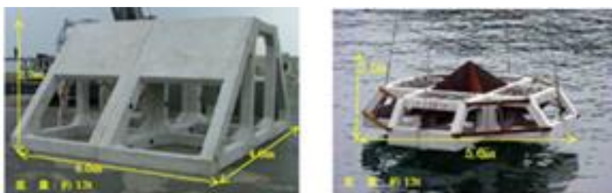
図Ⅱ-1-27 攪拌ブロック礁
