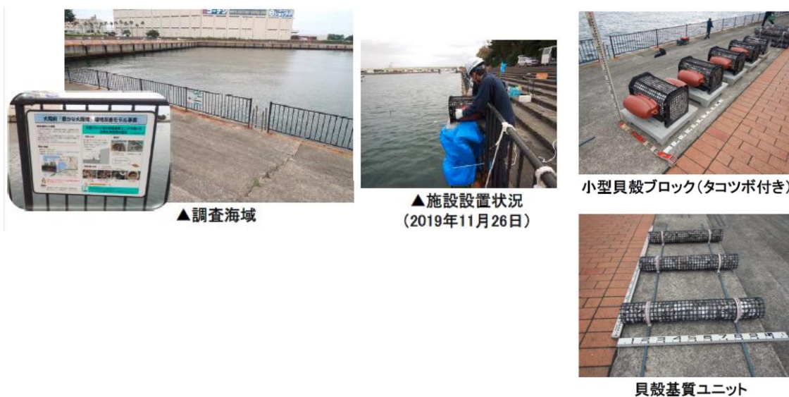
15 図Ⅱ-1-23 泉大津旧港階段岸壁での設置状況（左）及び設置した基質（右）
