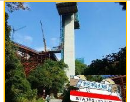
途中で新名神の工事現場を通ります
