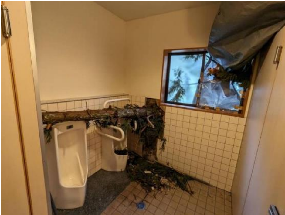
【倒壊危険ありと判断された避難所の様子】 木が避難所の外壁を突き破り室内に進入している
