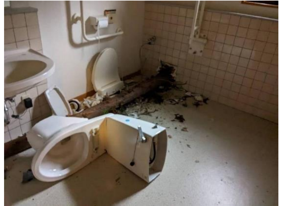
【倒壊危険ありと判断された避難所の様子】 木が避難所の外壁を突き破り室内に進入している
