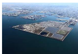
泉大津沖処分場
