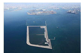
大阪沖処分場
