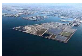
泉大津沖処分場
