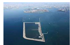
大阪沖処分場
