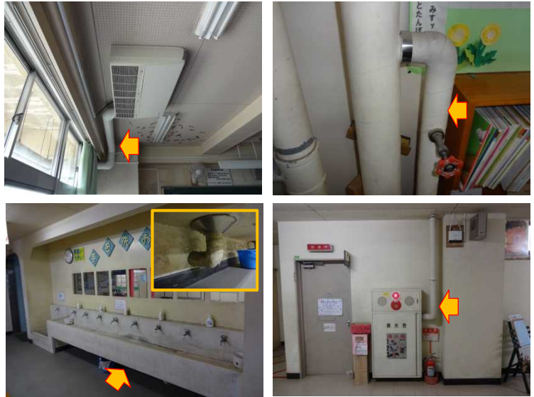
写真①（露出配管の状況）
