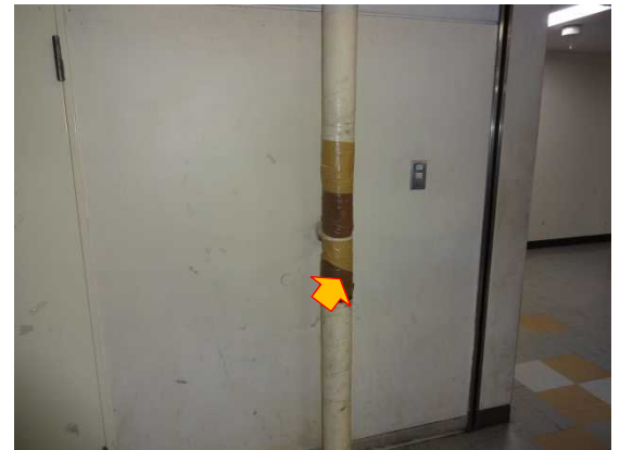
写真④（応急処置の状況）
