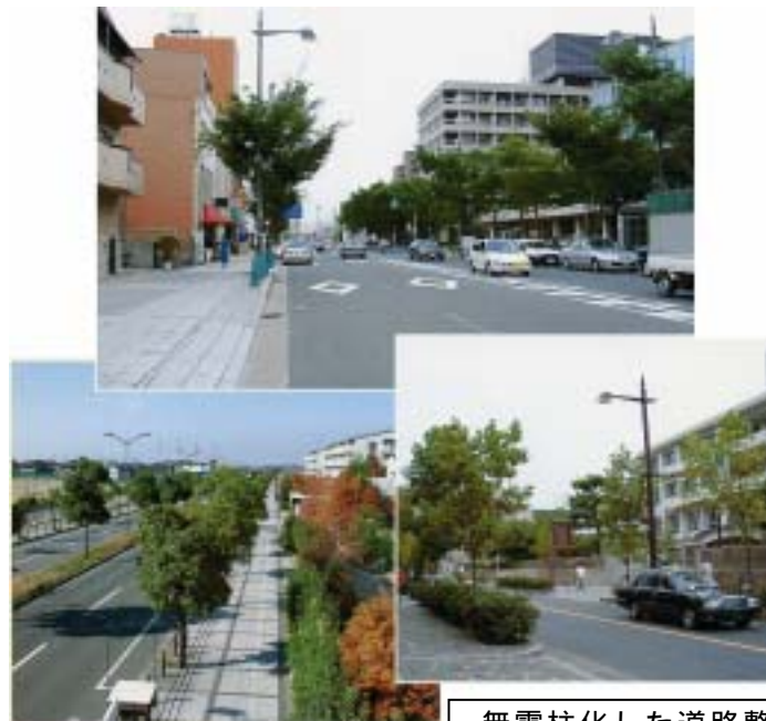
無電柱化した道路整備例
