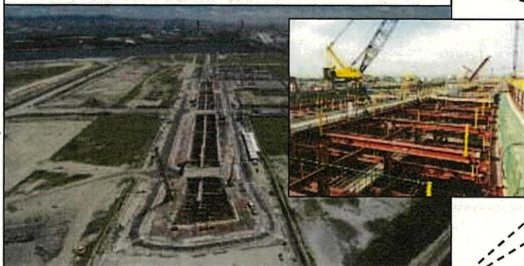
【10】鉄道駅舎建設工事の状況
