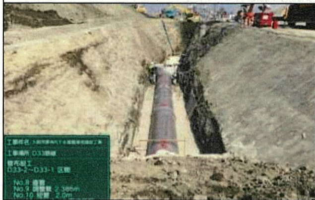
【7】下水管敷設工事の状況
