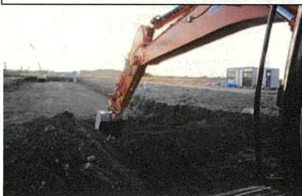
【5】観光外周道路新設工事の状況
