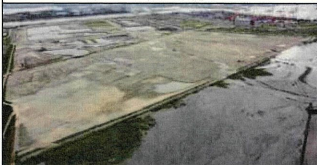
【1】【2】埋立・盛土工事の状況
