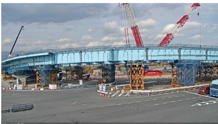
(仮称) 夢洲北高架橋架設状況 (令和5年11月時点)
