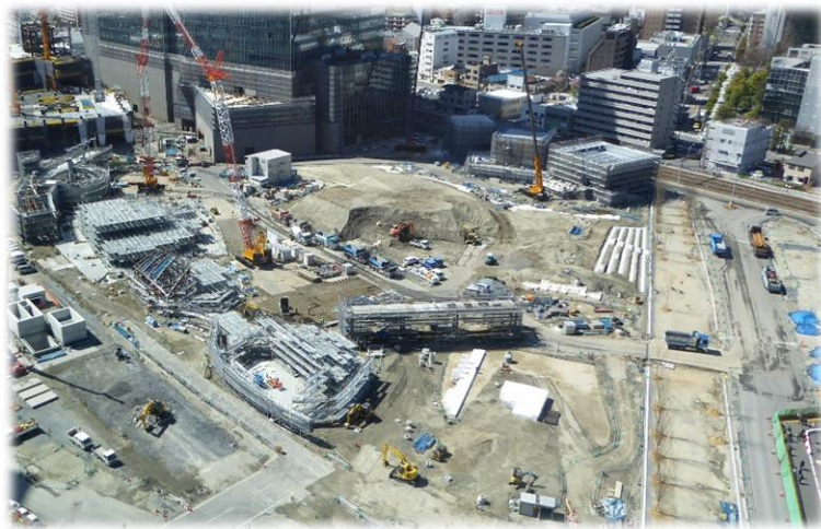
◆ うめきた2期公園の施工状況（令和5年3月撮影）
