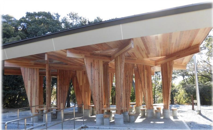
◆ 新技術（CLT材）を活用した休憩所の新設（服部緑地）
