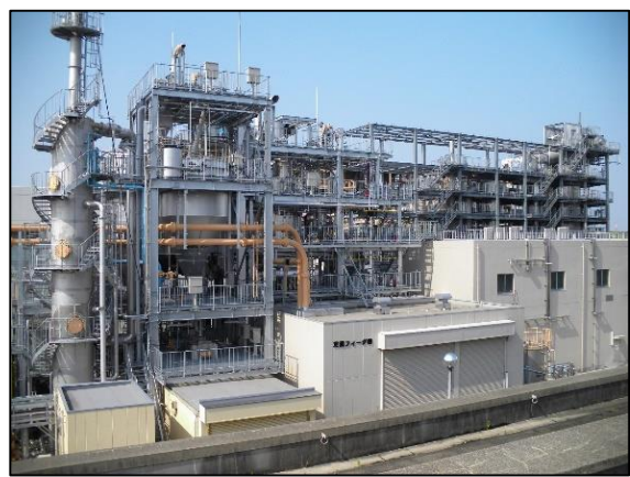
安定した下水道サービスを確保するための 着実な改築更新(焼却炉)
