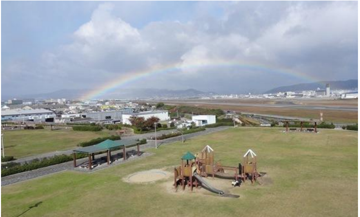
原田水みらいセンター水処理施設上部の芝生広場 出典：豊中市ホームページ(スカイランドHARADAの紹介)
