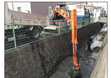
廿田川(にじゅうでんがわ)底泥の浚渫(大東市)
