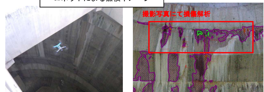
ロボットによる点検イメージ
