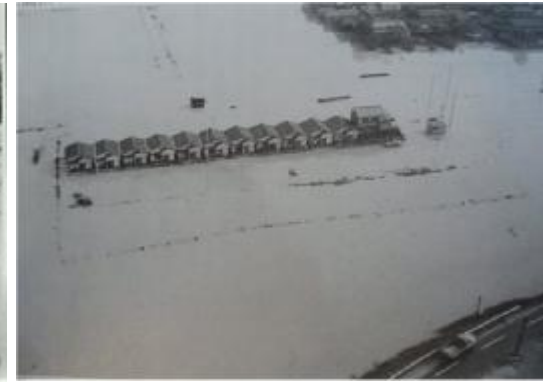
昭和42年7月被災写真(女瀬川)
