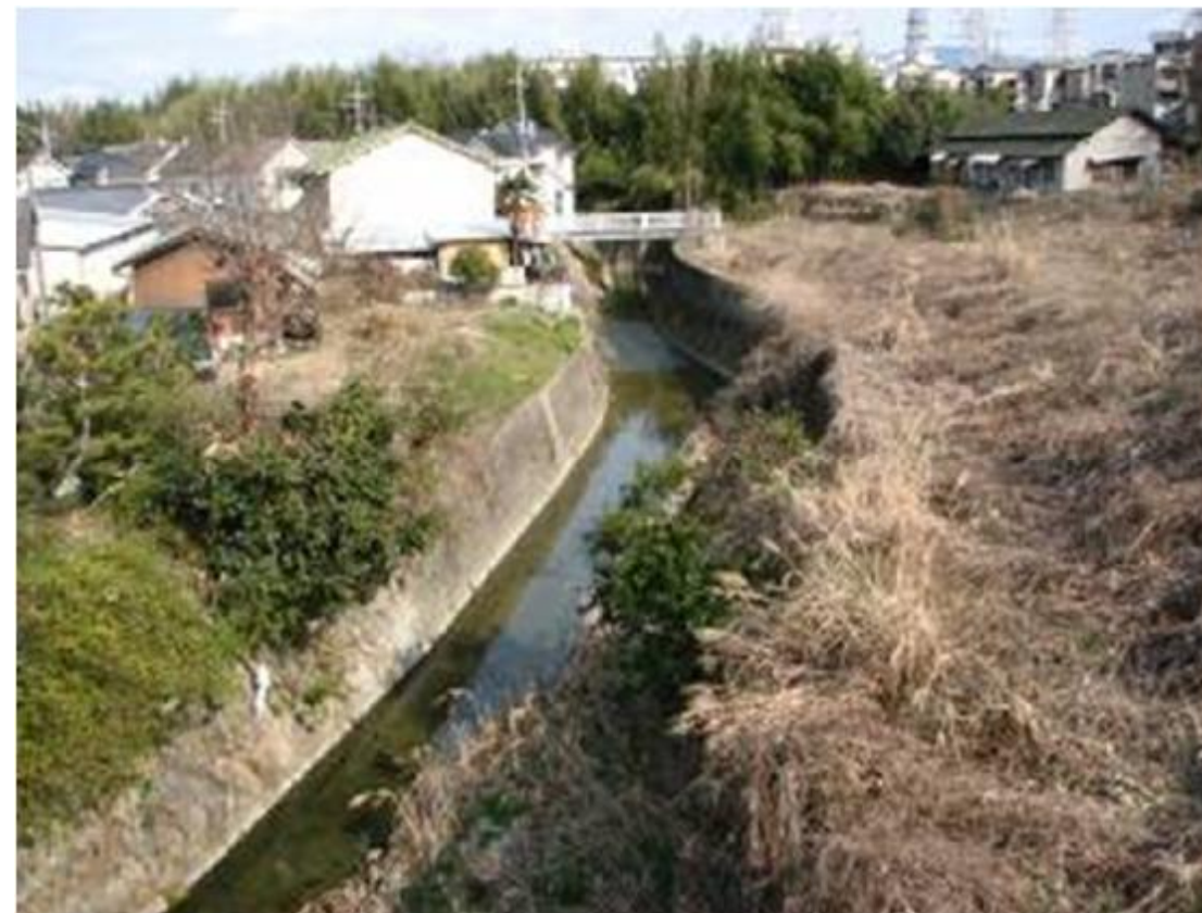
西除川(狭山池ダム上流)
