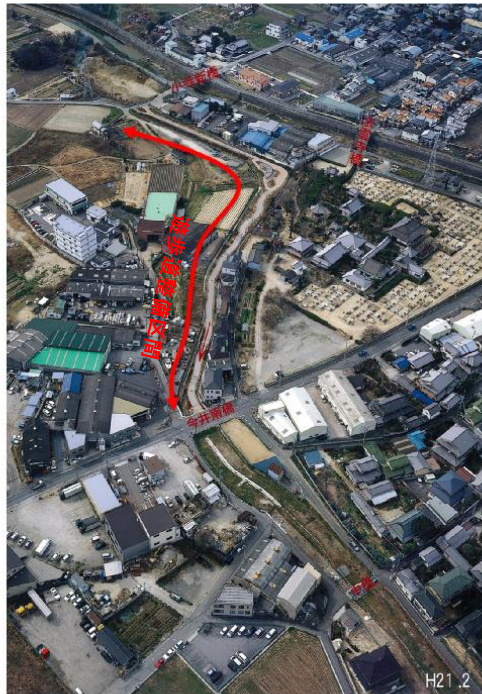
西除川旧河川敷遊歩道整備
