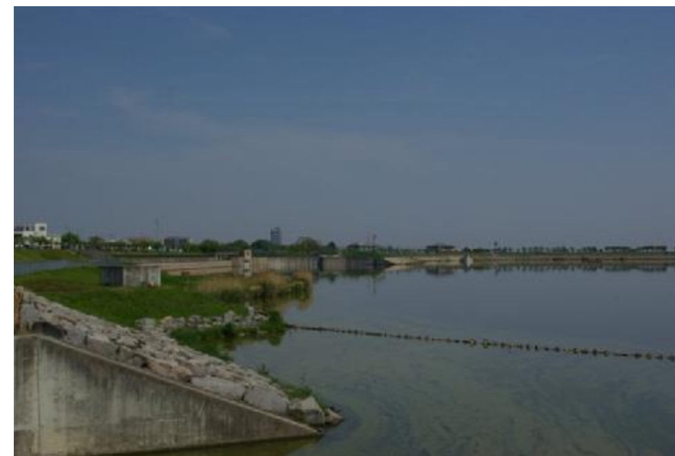
狭山池ダム アオコ発生状況(西除川流入部)
